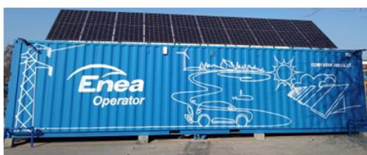
Baza: Kontener morski 40 stopowy HC
